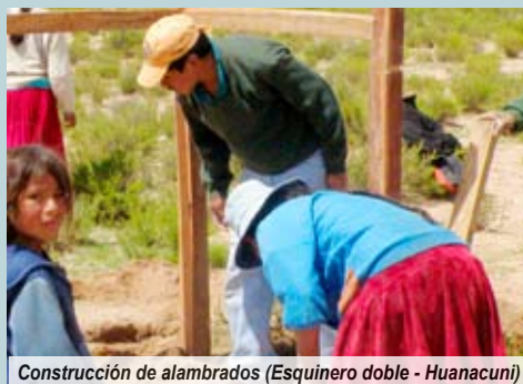
Construcción de alambrados (Esquinero doble - Huanacuni)
